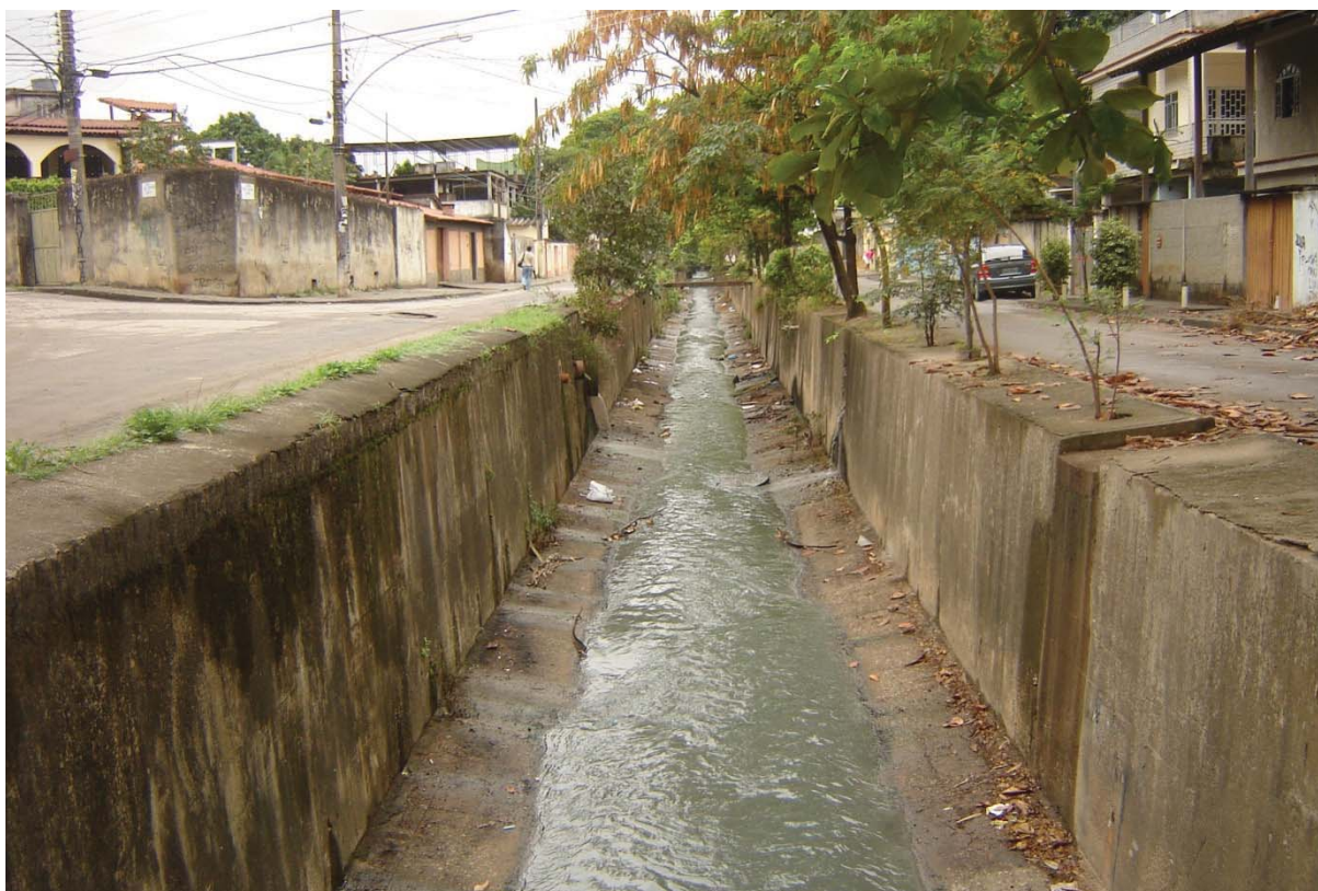
Figura 2.6 – Exemplo de canalização com uso de concreto (Acervo pessoal) 6
