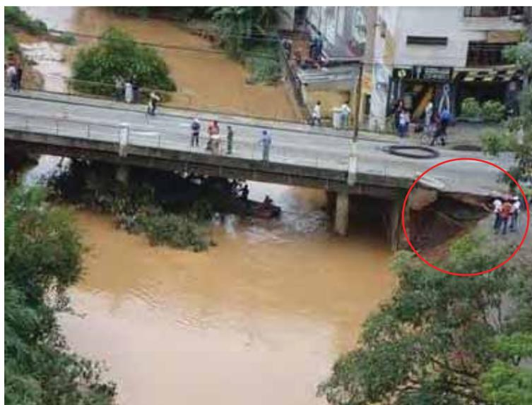
**Figura C.6: Ponte que teve sua estrutura comprometida após enchente em dezembro de 2010.**
