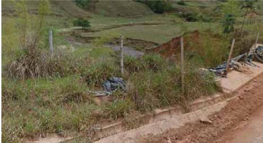
**Figura C.131: Desbarrancamento de parte da estrada causada pela erosão.**
