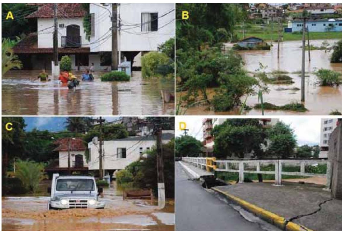
**Figura 3.5: Imagens da enchente de março de 2010 mostrando o nível da água (A, B e C) e o estrago que a força da água fez na ponte na Av. Presidente Kennedy ao comprometer um de seus pilares. Fonte: Diário do Vale.**
